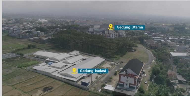
Gedung Isolasi Terpisah dari Gedung Utama
